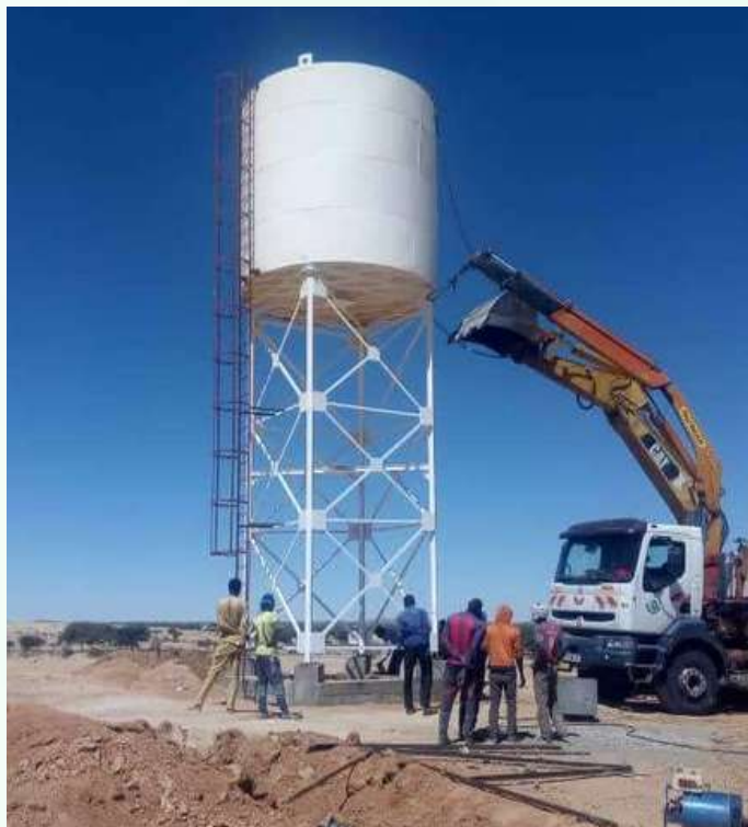
Projet de stockage d'eau à bagourfou
